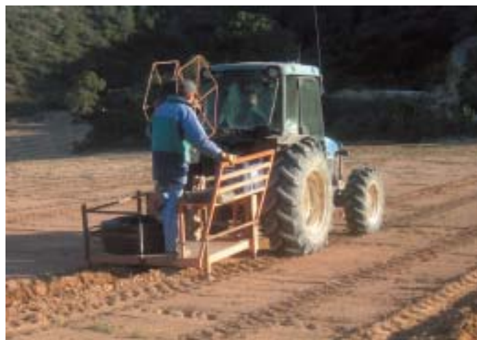
Proceso de enterrado de la tubería de goteo
