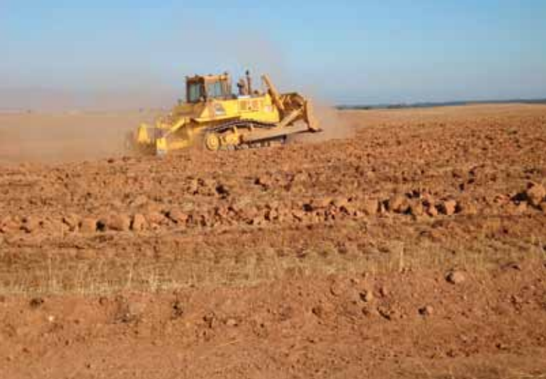
Subsolado profundo antes de la plantación
